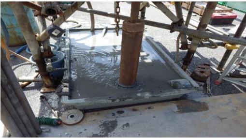
写真-8 推進中の状況-1
