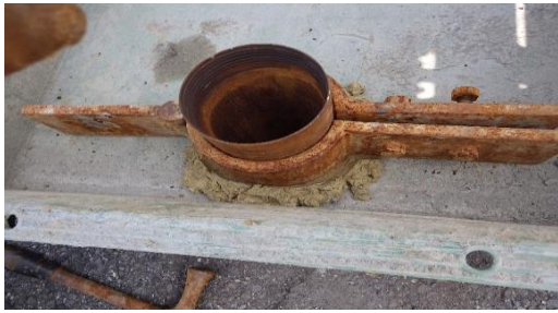
写真-7 遮水状況-3
