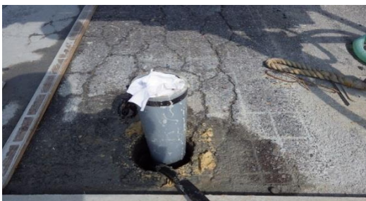
写真-10 推進中の状況-3
