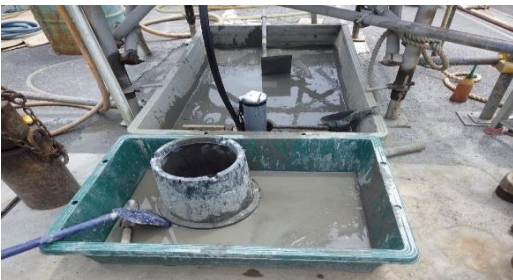
写真-9 推進中の状況-2
