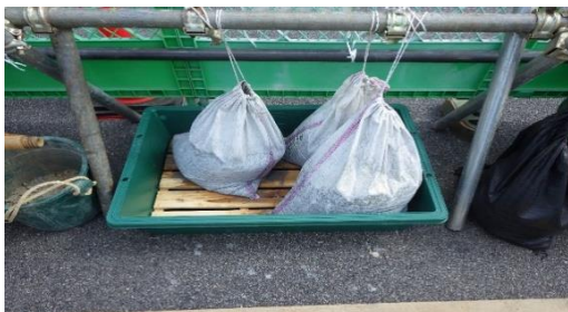
写真-3 土嚢袋にスライムを収めた状況
