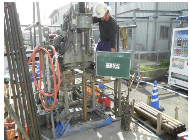
写真-1 作業状況
