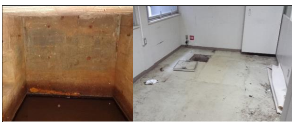
地下ピットの状況
