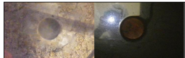
コンクリート削孔後
