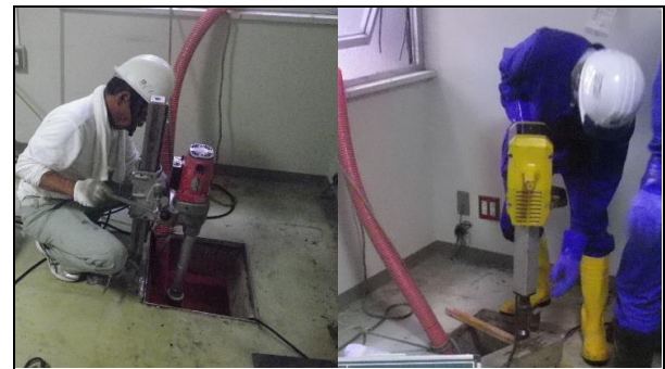
コンクリート削孔
