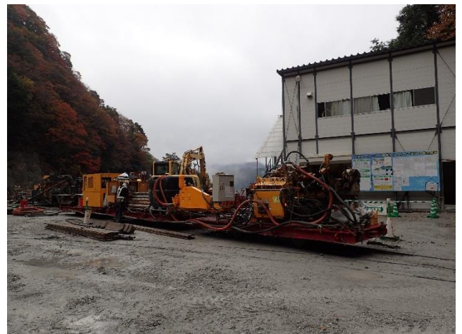
写真-1 平台車連結状況
