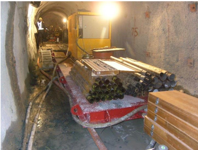
写真-2 坑内状況
