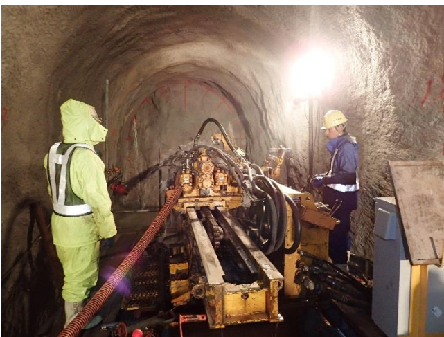
写真-3 掘削状況
